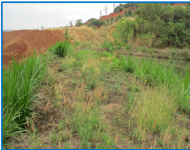
คันทำนบดิน และการปลูกพืชคลุมดินบ่อดังตะกอนบ่อที่ 1
